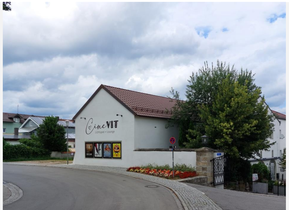
Das sanierte und erweiterte Kino Viechtach aus Blickrichtung Friedhofstraße
