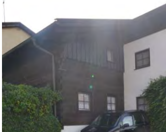
Baudenkmal Bäckergasse 24, Beispiel Holz- & Steinbau, um 1692 (Abb. Plankreis)
